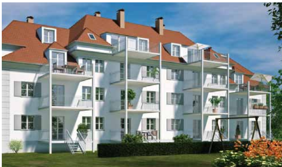
Das „Casa Bianca“ mit seinen 14 Wohneinheiten entstand in Augsburg in der Wolfzahnau. Die historische Substanz des Gebäudes blieb erhalten und wurde zeitgemäß instandgesetzt und mit großen Terrassen und Balkonen erweitert.
