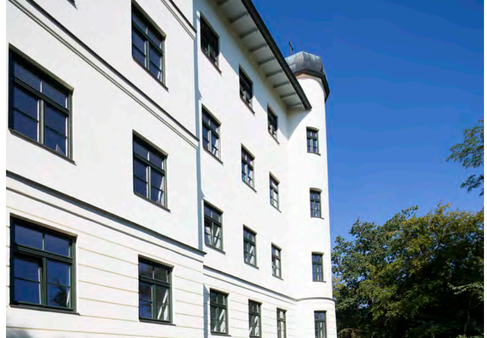
In Bobingen realisierte die AVANZA-Gruppe die komplette Sanierung des Einzelbaudenkmals „Schloß Straßberg“. Es entstanden 19 Wohnungen in stilvollem Ambiente, geprägt von einzigartiger Ausstrahlung und Stimmung sowie anspruchsvollem Design.
