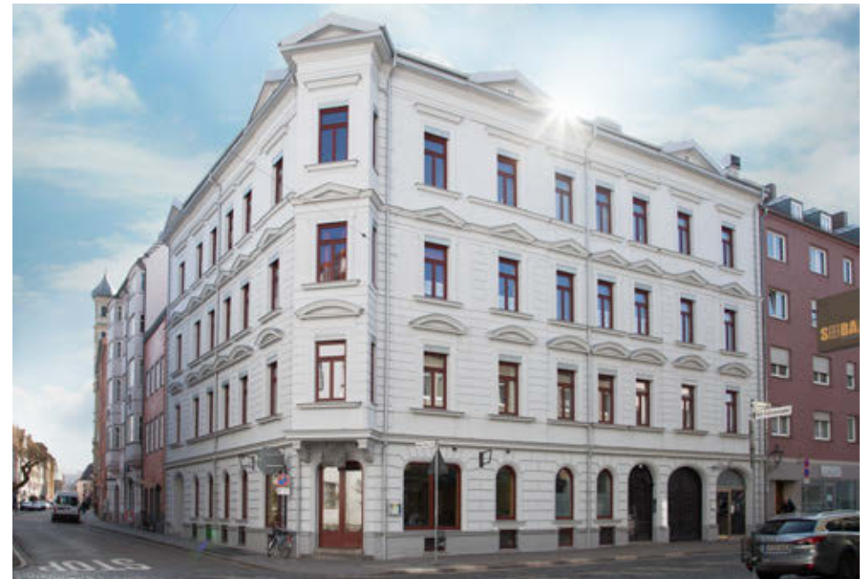
In Augsburg realisierte die AVANZA-Gruppe die komplette Sanierung des Einzelbaudenkmals „Klinkertor Nr. 1“. Es entstanden Wohnungen in stilvollem Ambiente, geprägt von einzigartiger Ausstrahlung und Stimmung sowie anspruchsvollem Design.
