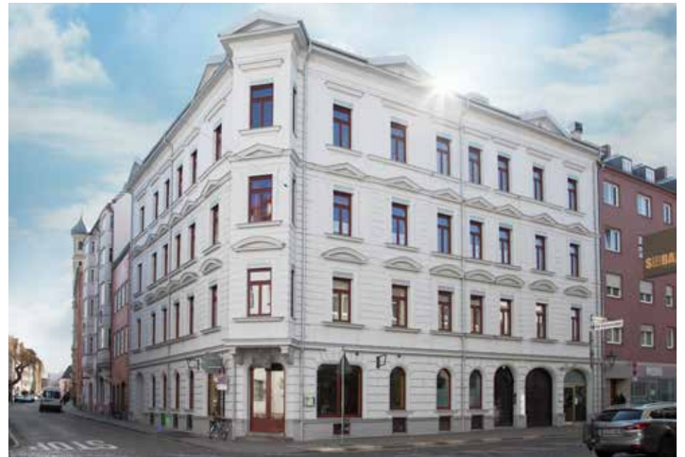
In Augsburg realisierte die AVANZA-Gruppe die komplette Sanierung des Einzelbaudenkmals „Kliniktor Nr. 1“.
